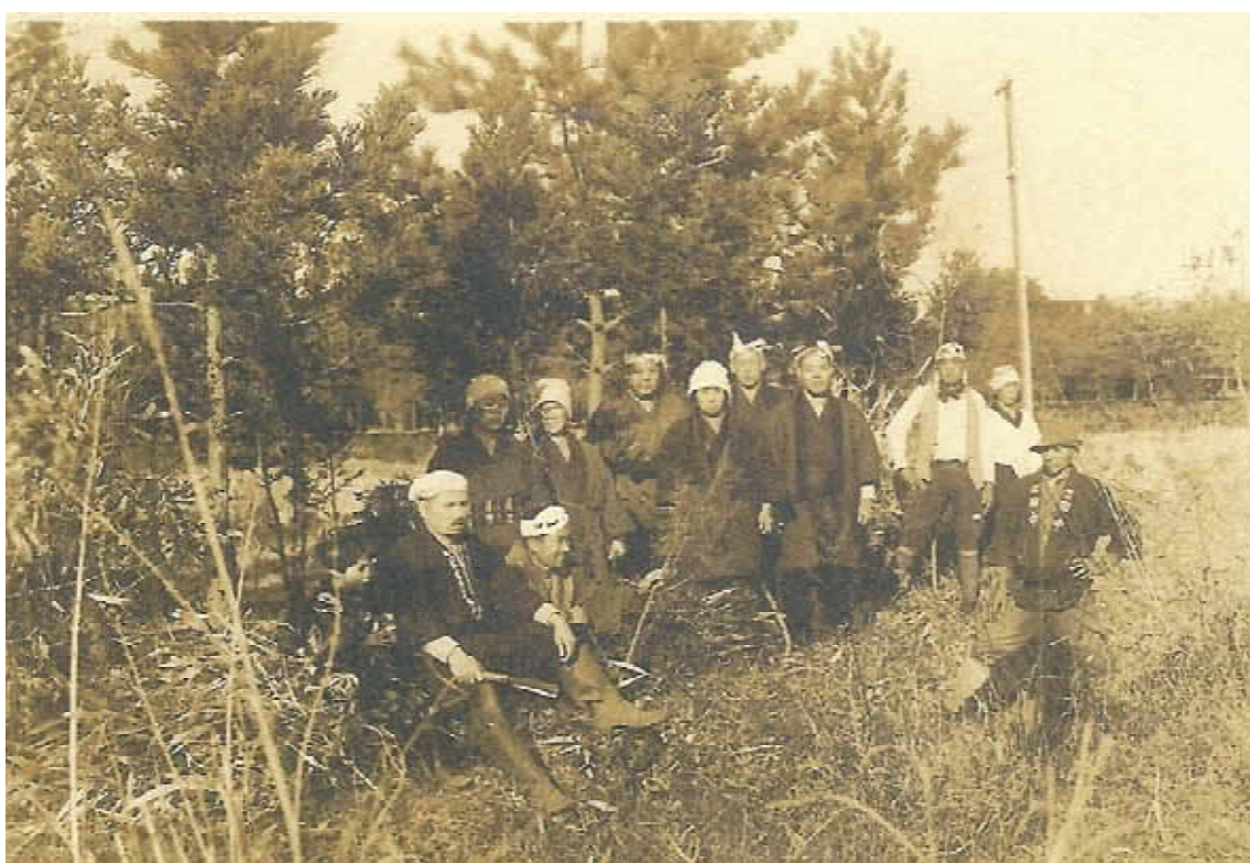
磐城国際無線電信局 富岡受信所建設工事開始 地均しに従事する深谷地区の皆さん (大正8年) 深谷亘美さん提供
