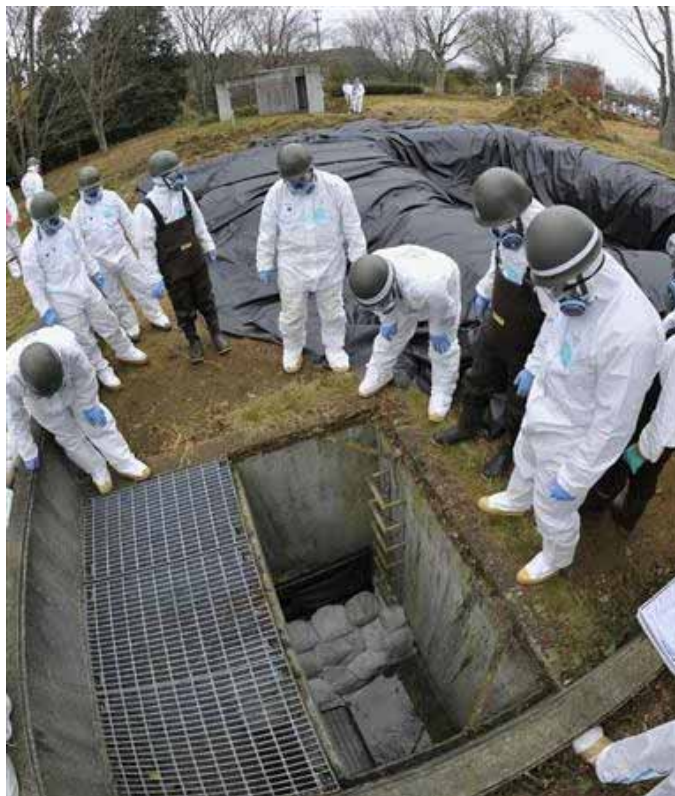
( 富岡町役場排水溝の除染作業 )
